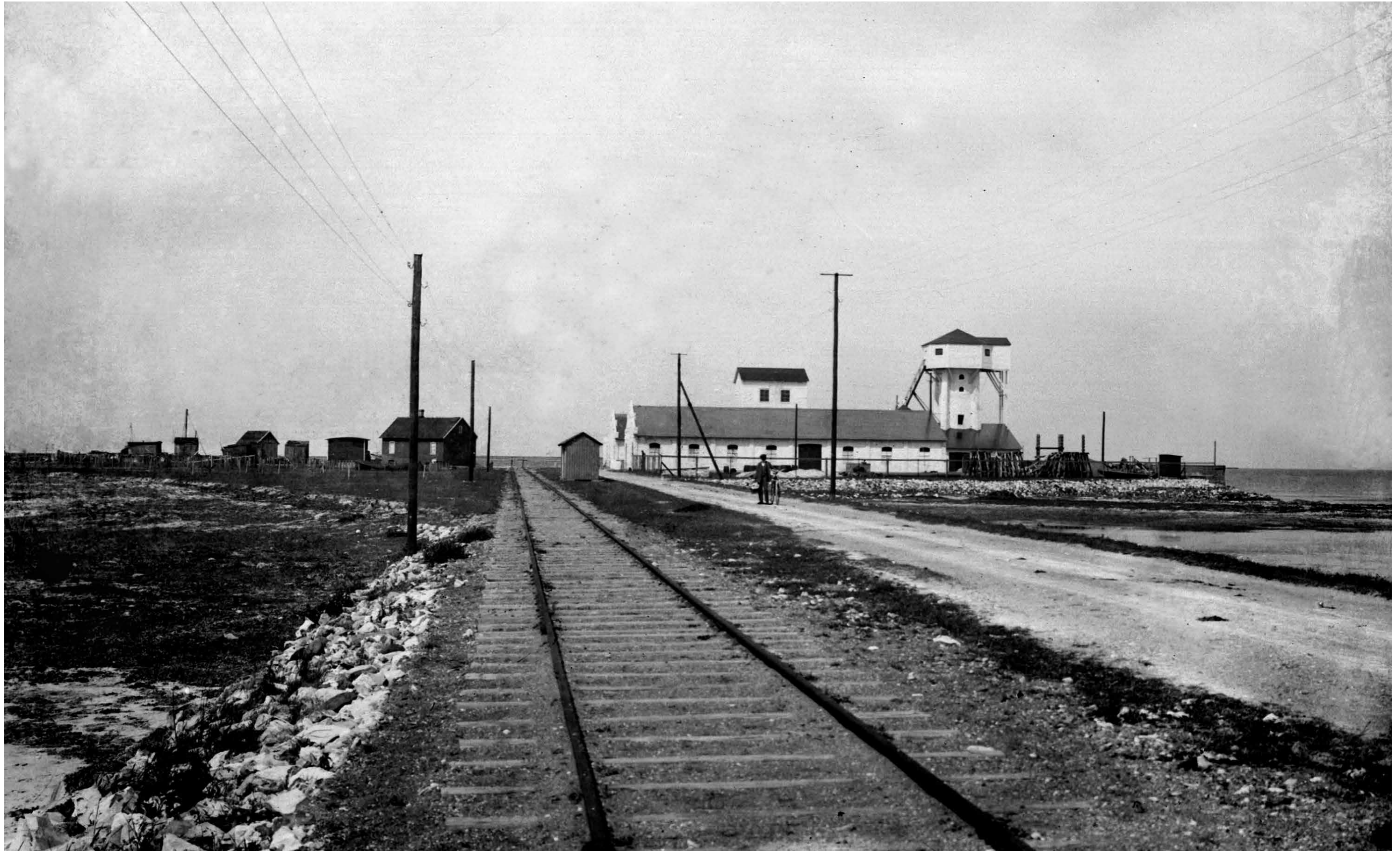
Här är fabriken fullt utbyggd. Vattentornet i mitten och runt om byggnader för ånggenerator, bränning av cement, malning av kalkmjöl med mera. Hamnkontoret skymter till vänster.
